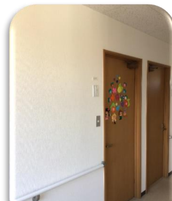
廊下クロスの張替
